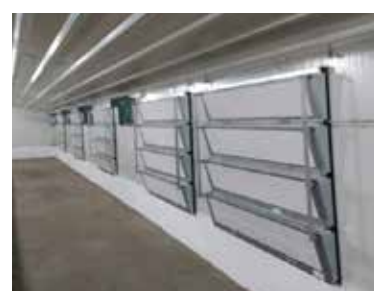
Sistema de compuerta de túnel tipo mt
